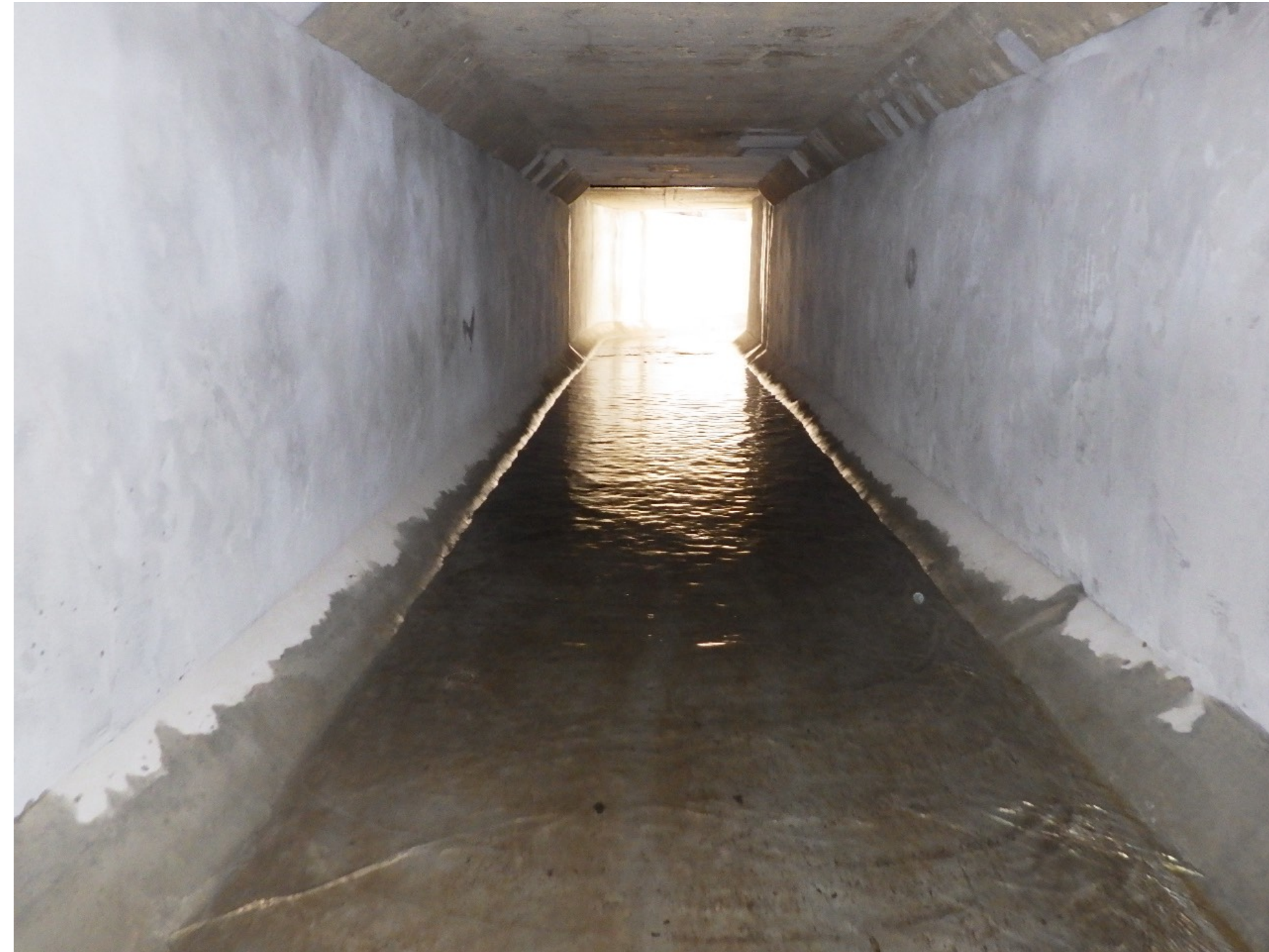
(a)水路トンネルの一例
